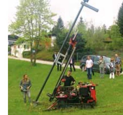
Einfache Montage einer Solarlampe mit Schraubfundament.
